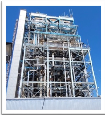
Reparaciones de Plantas de Generación Eléctrica (Genera)
