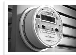
Instalación de Metros Inteligentes (LUMA)
