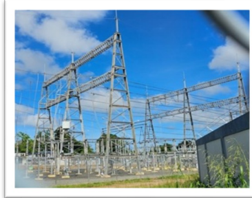
Reparación de Subestaciones (LUMA)
